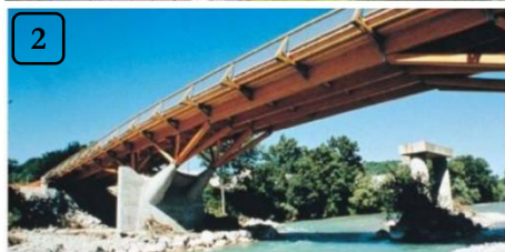
Ouvrages d'art en bois
